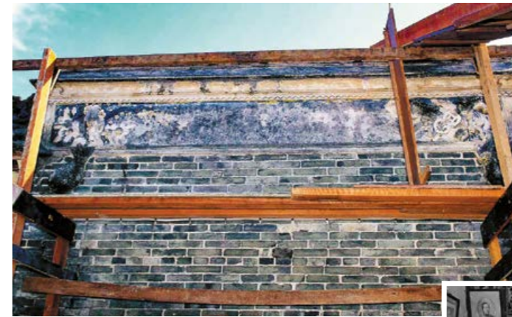
The renovation in 1995 1995年的修復工程
